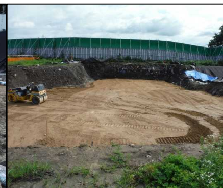
①有害物掘削除去工
