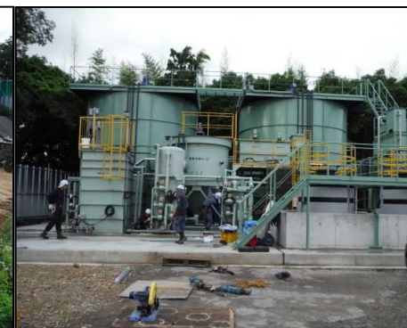
⑤浸透水处理施設工
