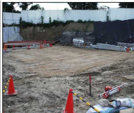
①有害物掘削除去工
