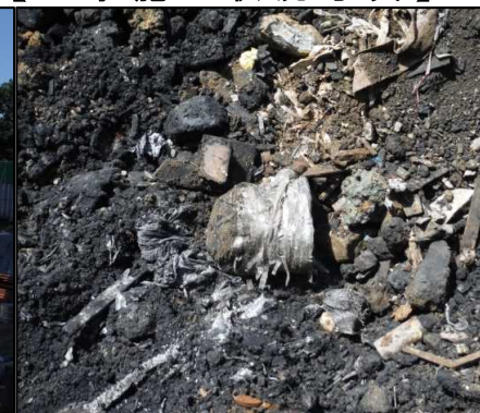
①有害物掘削除去工
