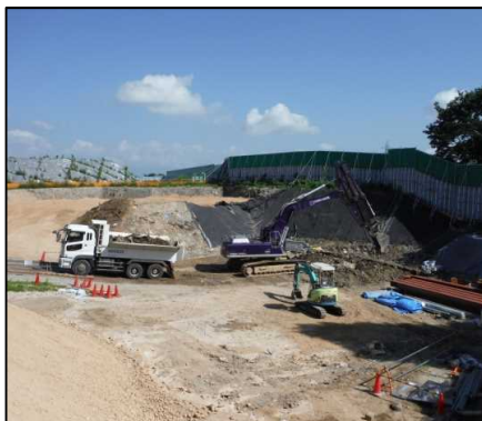
①有害物掘削除去工
