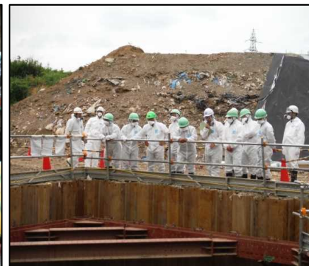
①有害物掘削除去工
