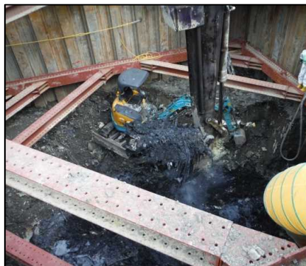
①有害物掘削除去工
