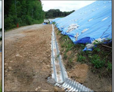
⑤汚染地下水拡散防止対策工
