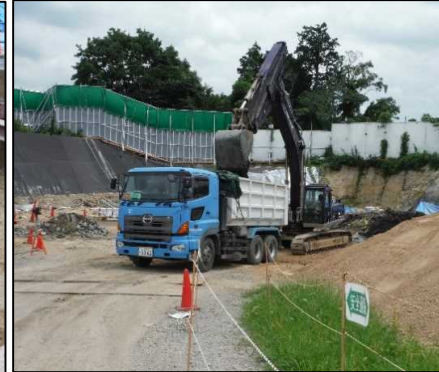
①有害物掘削除去工
