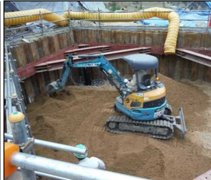
①有害物掘削除去工
