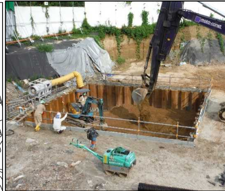
①有害物掘削除去工
