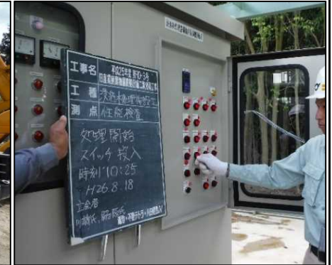
⑤浸透水处理施設工
