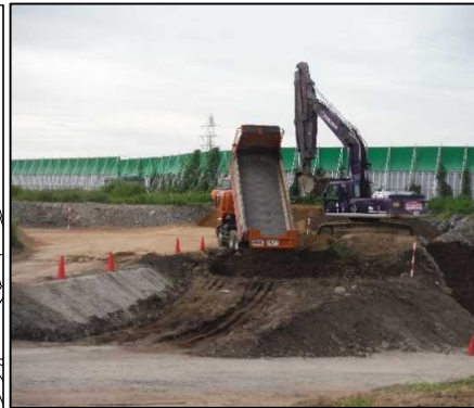
①有害物掘削除去工
