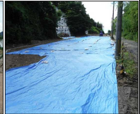
④仮設備工
