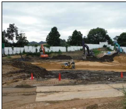
①有害物掘削除去工
