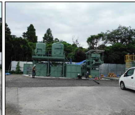
④浸透水処理施設工
