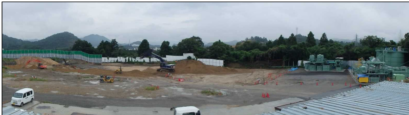
①有害物掘削除去工
