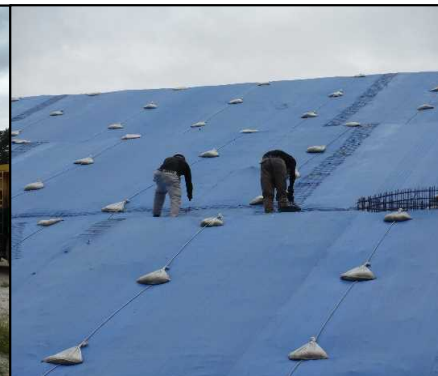
④仮キャッピング工
