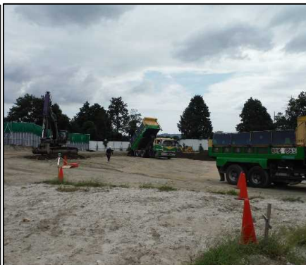
①有害物掘削除去工
