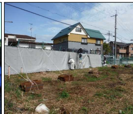
④仮設備工
