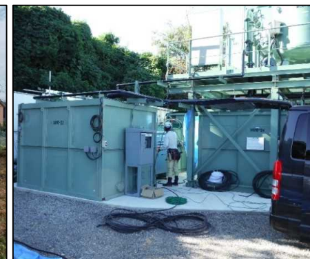
⑤仮設濁水处理施設設置工
