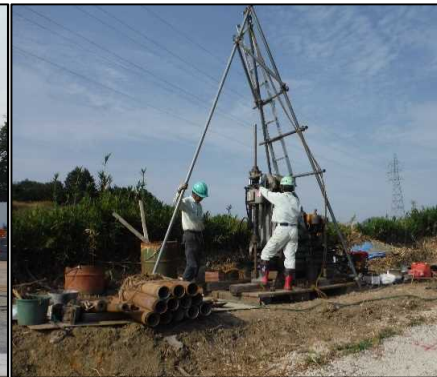
③鉛直遮水壁工
