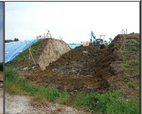
④仮設備工
