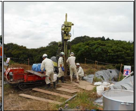
②底面遮水工
