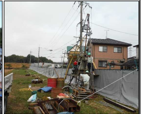
③鉛直遮水壁工
