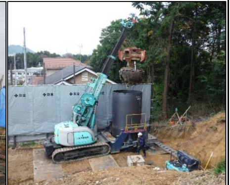
③ 鉛直遮水壁工
