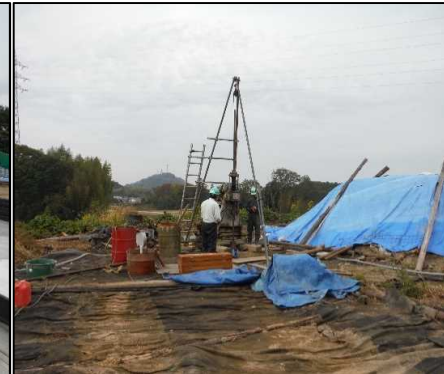
② 底面遮水工
