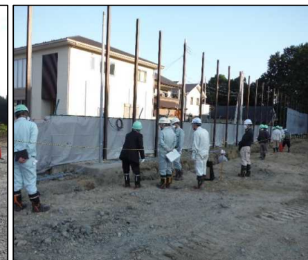
③ 鉛直遮水壁工
