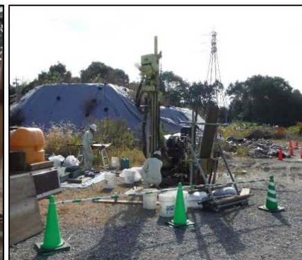
② 底面遮水工
