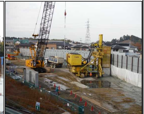
② 鉛直遮水壁工
