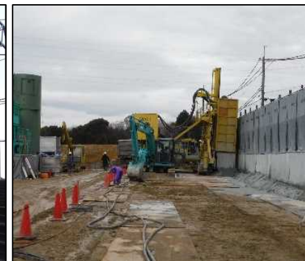
③ 鉛直遮水壁工
