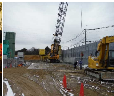
③ 鉛直遮水壁工
