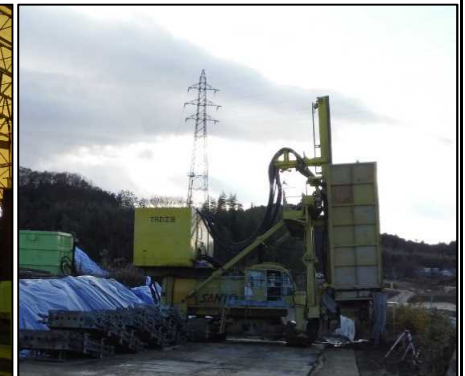
③ 鉛直遮水壁工
