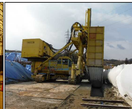
③ 鉛直遮水壁工
