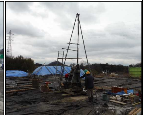
③ 事前調査ボーリング
