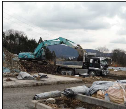
① 選別土仮置・盛土工
