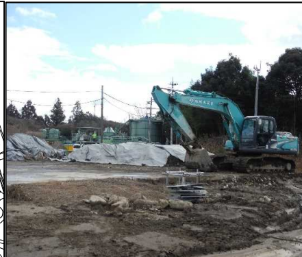
① 選別土仮置・盛土工
