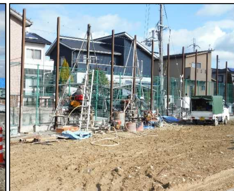
④ モニタリング設備工
