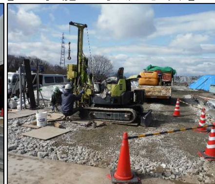
③ 事前調査ボーリング工
