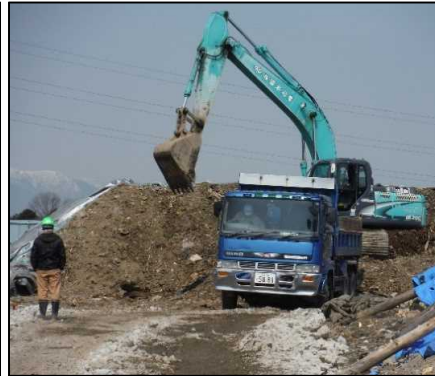
① 選別土仮置・盛土工
