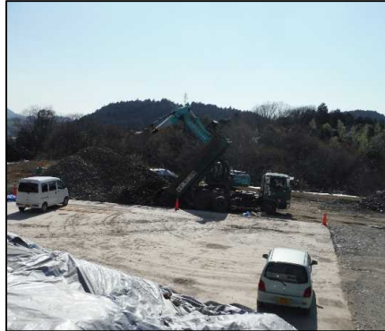
① 選別土仮置・盛土工
