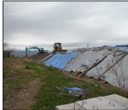
① 選別土仮置・盛土工
