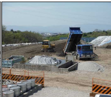
① 選別土仮置・盛土工
