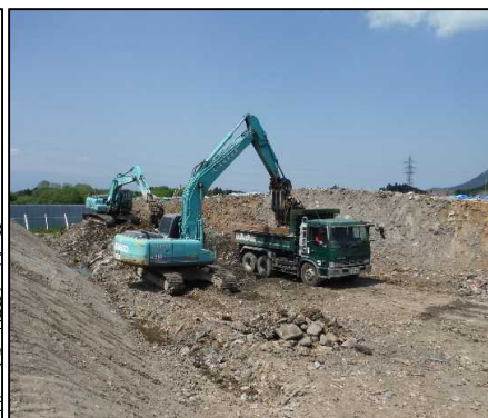
① 選別土仮置・盛土工
