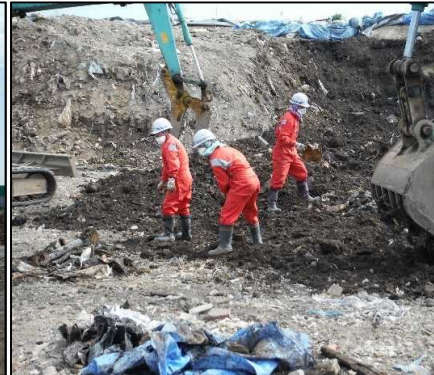
① 選別土仮置・盛土工
