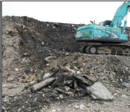
① 選別土仮置・盛土工
