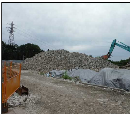
① 選別土仮置・盛土工 選別再生資源(岩、アスファルト、コンクリート)の仮置き状況です。
