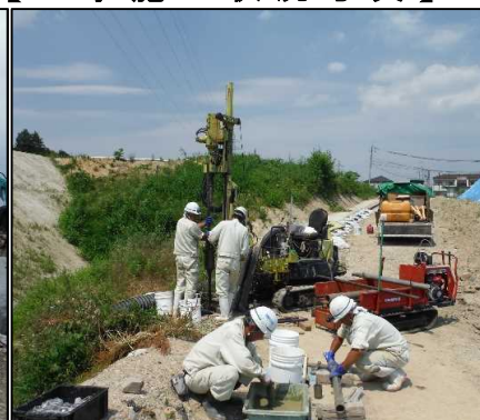
② 矢板工 国道側境界付近の止水矢板工施工予定箇所での調査ホ-リングを行っています。
