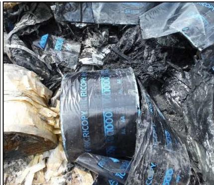
② 選別土仮置・盛土工
