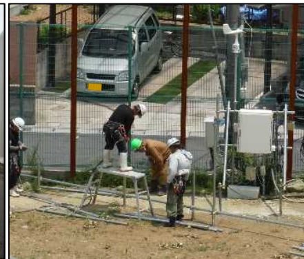
③ 環境対策設備工 仮囲いの設置のために計測器のすぐそばで単管を打込んでいます。
