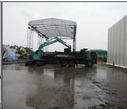
② 選別土仮置・盛土工 乾燥テントに仮置きしていた廃棄物土を選別施設内へ運搬しています。
