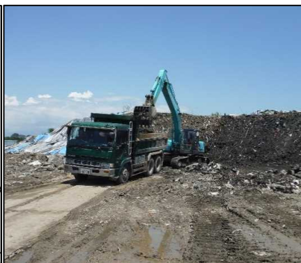
① 仮置物撤去工
