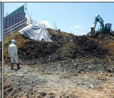
② 廃棄物土掘削工
