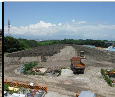
③ 選別土仮置・盛土工
