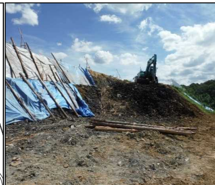
② 廃棄物土掘削工 A工区の法面を掘削しているところです。
