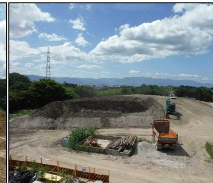
③ 選別土仮置・盛土工 選別した土は場内に仮置きしています。
