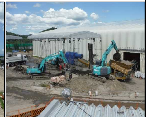
⑤ 選別処理工 重機や人の手によって粗選別をしています。
