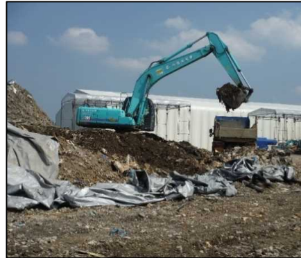
① 仮置物撤去工 廃棄物土を掘削し、運搬しています
