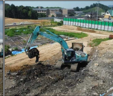
② 廃棄物土掘削工 A工区の掘削状況です。
