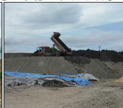
③ 選別土仮置・盛土工
