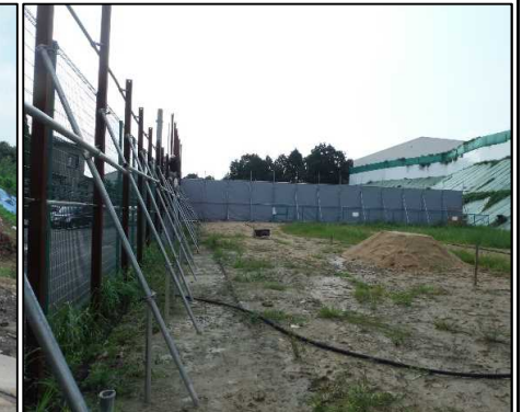
⑤ 既設井戸閉塞工
