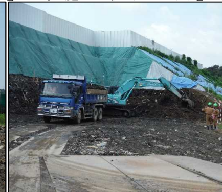
② 廃棄物掘削工
