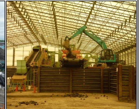
⑤ 選別処理工 自走式スクリーンへ廃棄物土を投入しています。
