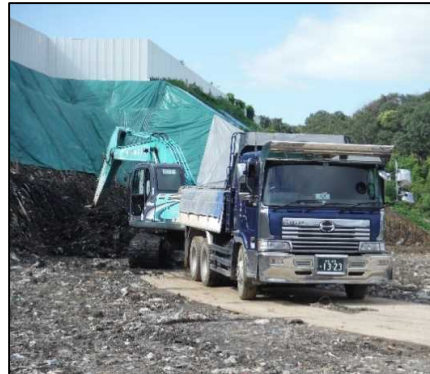
② 廃棄物土掘削工 A工区の廃棄物土を掘削しています。
