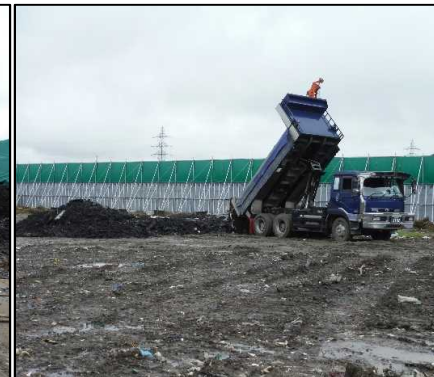
① 廃棄物土掘削工
