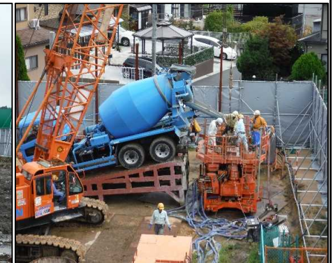
⑤ 既設井戸閉塞工
