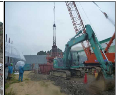
⑤ 既設井戸閉塞工
