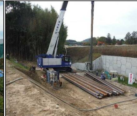
③ 矢板工 下流部止水矢板の圧入を行っています。
