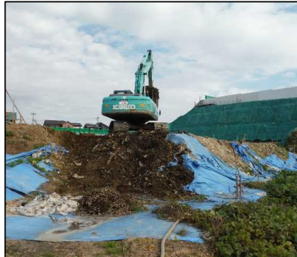
① 廃棄物土掘削工 A工区の廃棄物土を掘削しています。
