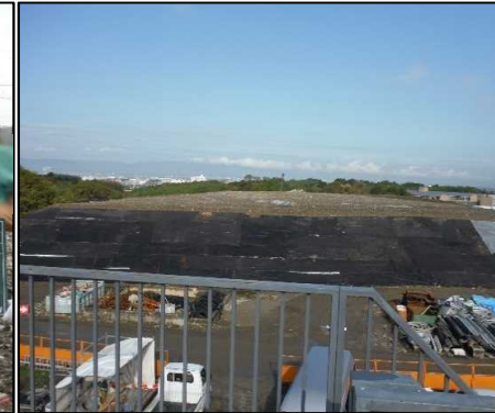
② 選別土仮置き・盛土工 分析を行い、問題の無い選別土を場内に仮置きしています。
