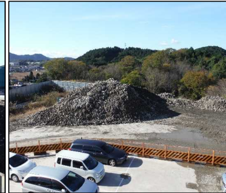
② 選別土仮置・盛土工
