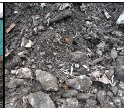
① 廃棄物土掘削工
