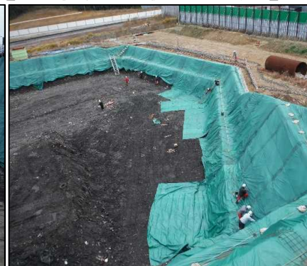
① 廃棄物土掘削工
