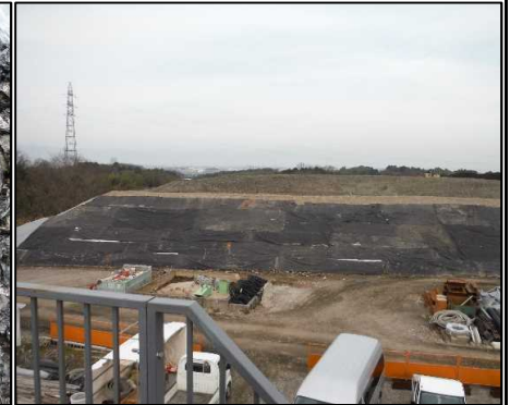
② 選別土仮置き・盛土工
