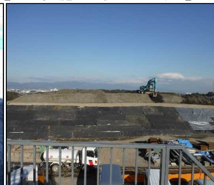
② 選別土仮置き・盛土工
