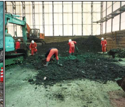
④ 選別処理工
