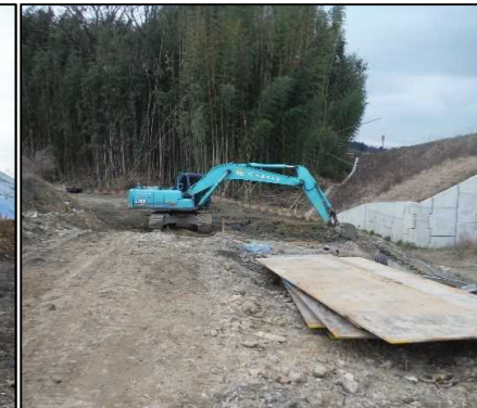
③ 廃棄物土掘削工
